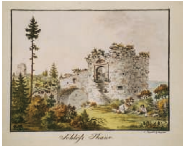
Die Reste der einstmal's größten Burgranlage im mittleren Inntal, gemalt von Caspar v. Pfaundler (1804). Der Zahn der Zeit hat weiterhin kräftig an den Mauern des Schlosses genagt.
